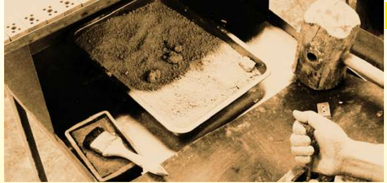
Reihenklammen aus Porzellan, mit der Hammerpresse hergestellt: Manuelles Abfüllen von Nassgranulat (Privatsammlung) Trocknen von Elektroporzellan nach dem Pressen (Privatsammlung)
